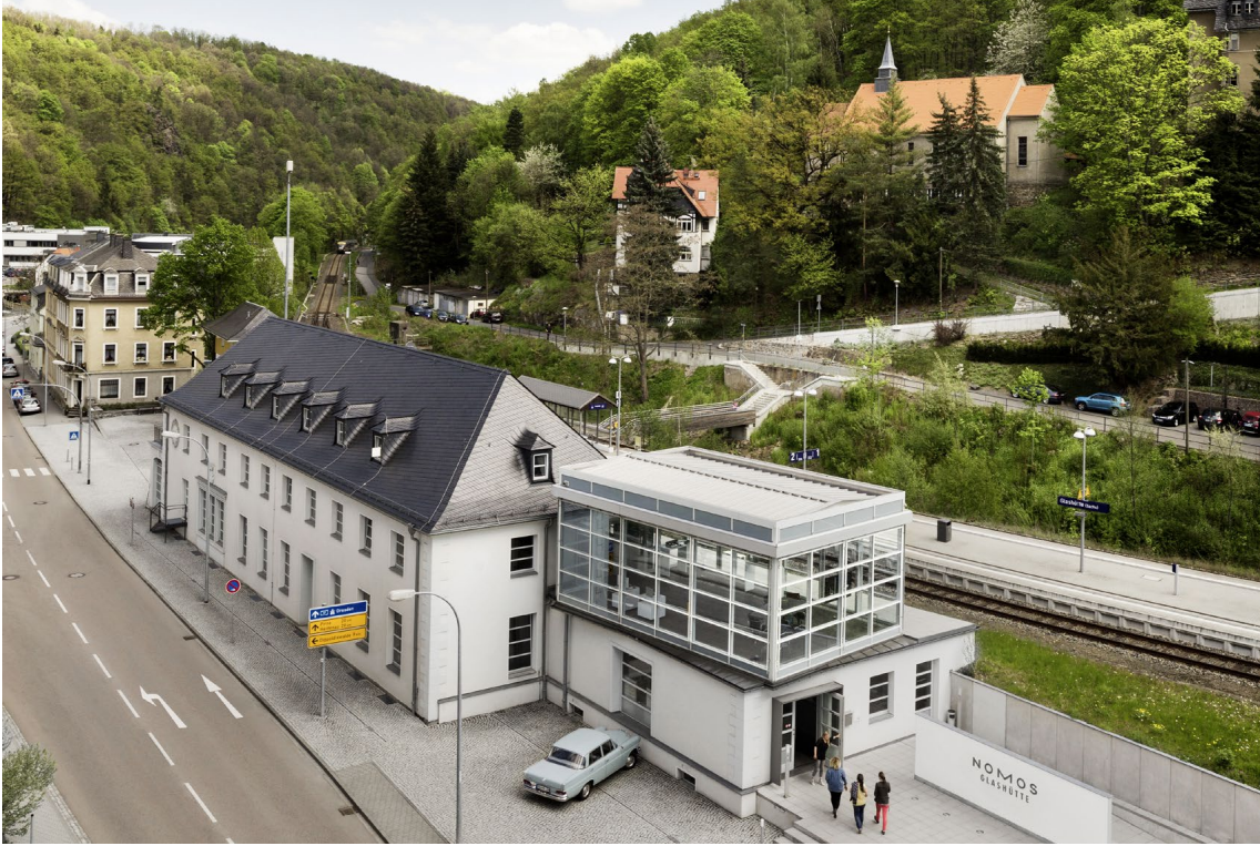
NOMOS-Zentrale im ehemaligen Bahnhofsgebäude von Glashütte
